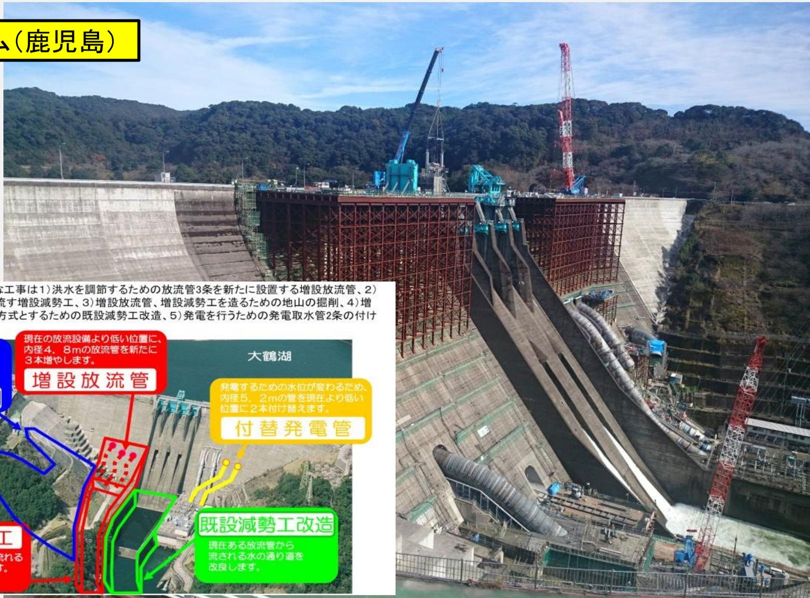
再開発事業に伴う主な工事は1)洪水を調節するための放流管3条を新たに設置する増設放流管、2)増設放流管から洪水を流す増設減勢工、3)増設放流管、増設減勢工を造るための地山の掘削、4)増設減勢工と同様の減勢方式とするための既設減勢工改造、5)発電を行うための発電取水管2条の付け替えの5つである。
